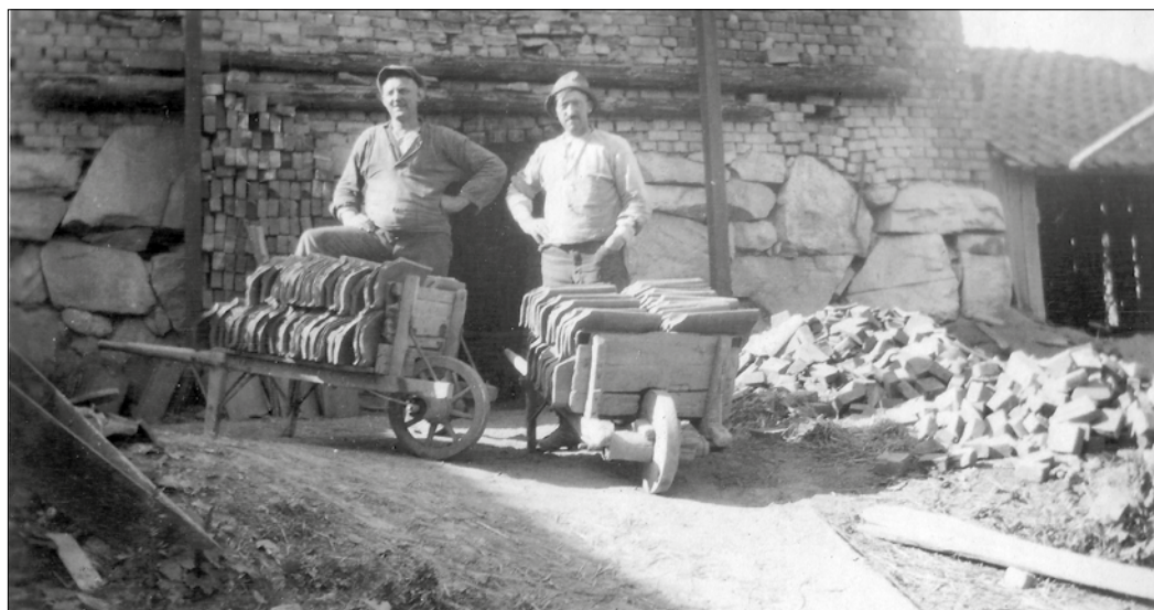
Olaf Døhlen (t.v.) og Ragnvald Thori jobbet i teglverket. Her trilles det ut ferdige taksteiner.
