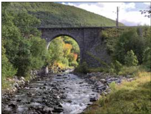
Vinstrabrua som ble satt opp i 1915
