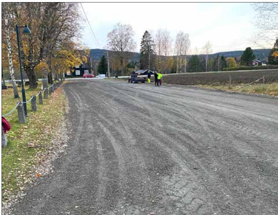
Det ble skikkelig fint etter at det lokale vegvesenet hadde tatt spadene i egne hender.
